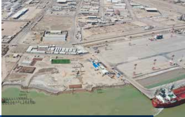
Basra Limanı'nın Yenilenmesi ve Rehabilitasyonu Projesi
