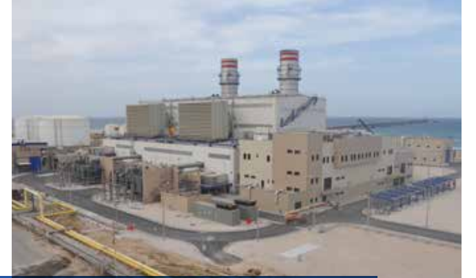
Al-Khums Basit Çevrim Elektrik Santrali
