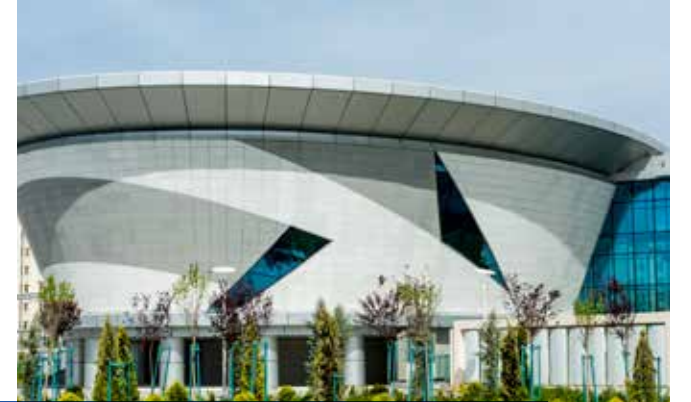
Aşkabat Basit Çevrim Elektrik Santrali
